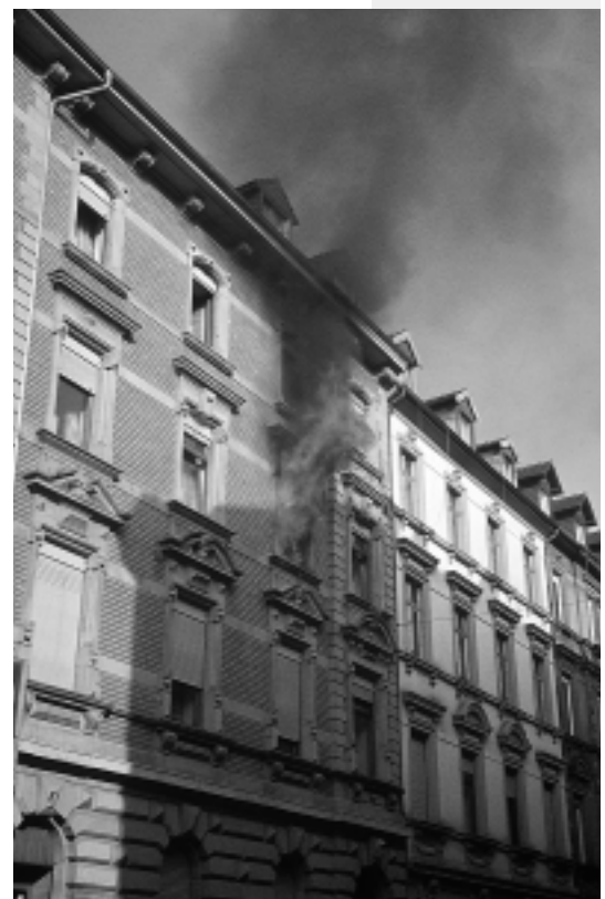
Brand- und Rauchausbreitungsgefahren an der Fassade
