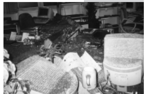
Brandschaden in einem Büro
